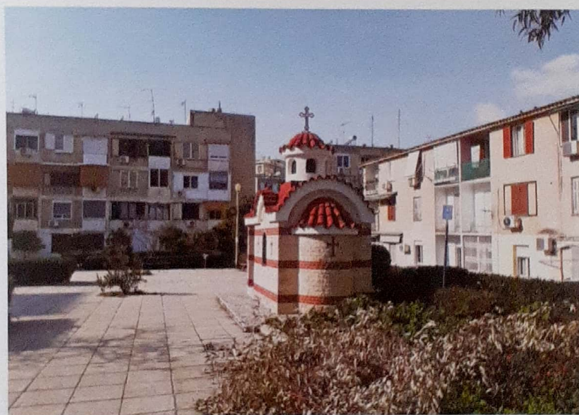
Εικ. 8-9. Επάνω, προπολεμικές προσφυγικές πολυκατοικίες της Καισαριανής, 2021· κάτω, ένα προκατασκευασμένο εκκλησάκι δίπλα στη μεγάλη εκκλησία του Αγίου Νικολάου στεγάζει την παλιά, την πρώτη Αγία Τράπεζα που είχε θεμελιωθεί εντός της φαρμακαποθήκης, διατηρώντας τη μνήμη της πρώτης αναδημιουργίας της κοινότητας· περιβάλλεται από μεσοπολεμικές και μεταπολεμικές προσφυγικές πολυκατοικίες, 2022
